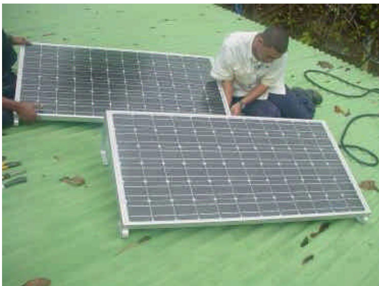
Figura 48: Técnico del ICE instalando los paneles solares sobre la estación en Gandoca.
